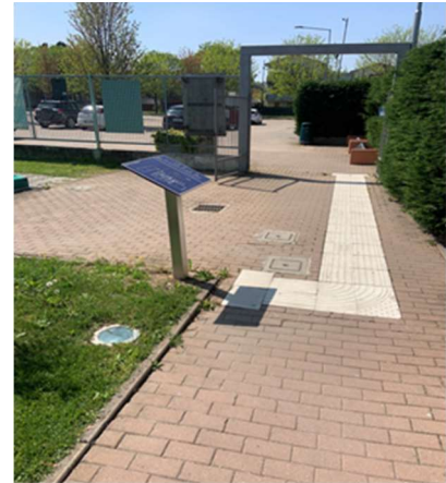
Figura 2 Ingresso con percorso LOGES a terra e mappa tattile
